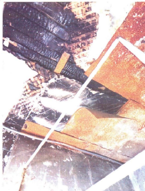
Фото 6. Повреждения деревянных перекрытий вследствие пожара
