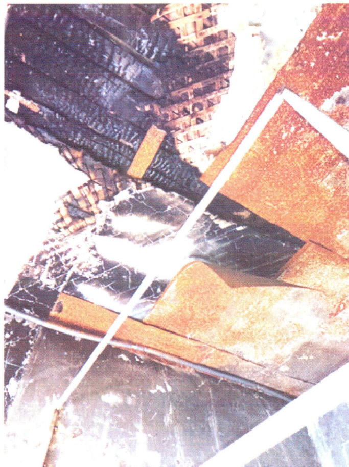
Фото 6. Повреждения деревянных перекрытий вследствие пожара
